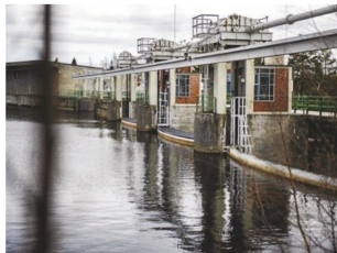
Kraftverket i Dönje, Bollnäs.
