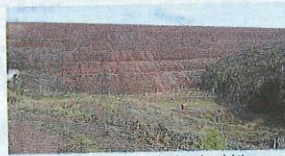
Trängslettdammen, värdefull för landets elproduktion, men ger väldigt lite till Älvdalens kommun där kraftverket ligger.
